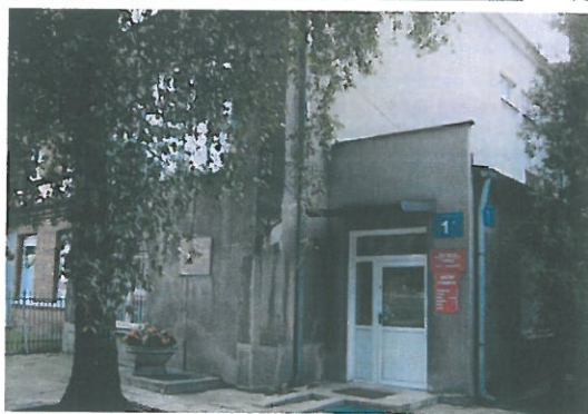
Zanim do budynku przy ul. Ogrodowej 1a wprowadziła się Biblioteka Pedagogiczna, przez kilkanaście lat działało tu kultowe kino „Hel”
